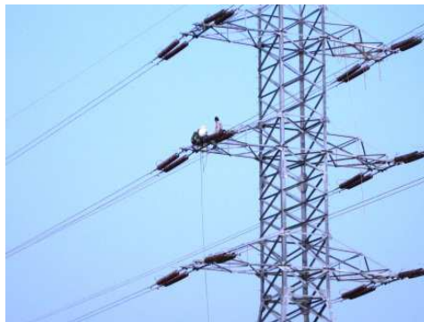
Hình 9: Căng dây 220 KV
