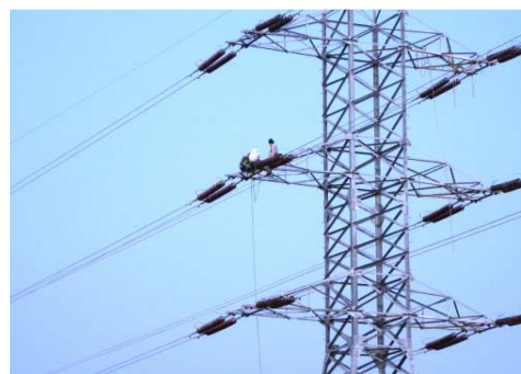
Đường dây 220KV Tuyên Quang – Yên Bái
