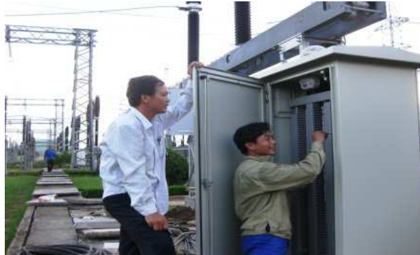
Hình 11: Xây lắp trạm biến áp 220 KV
