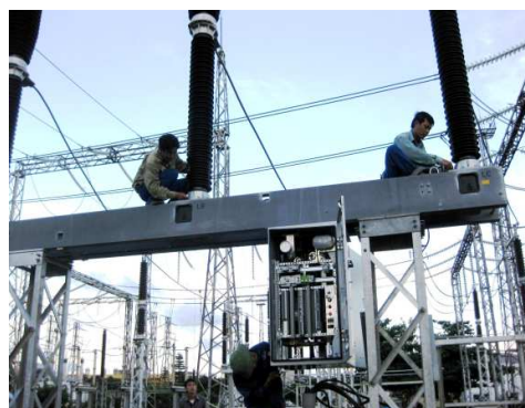
Trạm biến áp 220KV Đồng Hoà - Hải Phòng
