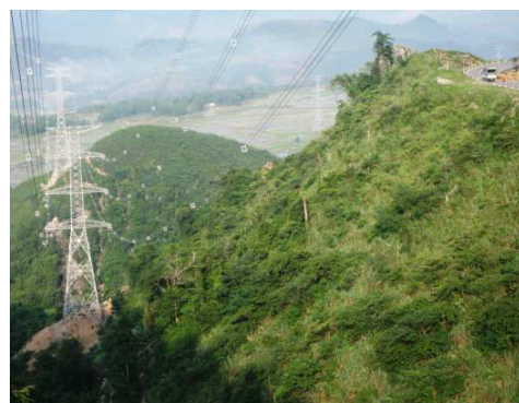
Đường dây 500Kv Sơn La – Hòa Bình
